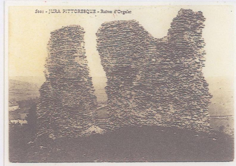
Les ruines du château au début du XX<sup>e</sup> siècle. La photo du haut fait apparaître clairement le processus de délabrement des murs : des couches verticales de pierres se délitent sous l'action des agents atmosphériques ce qui entraîne le basculement de pans entiers de muraille dont la stabilité n'est plus assurée.
