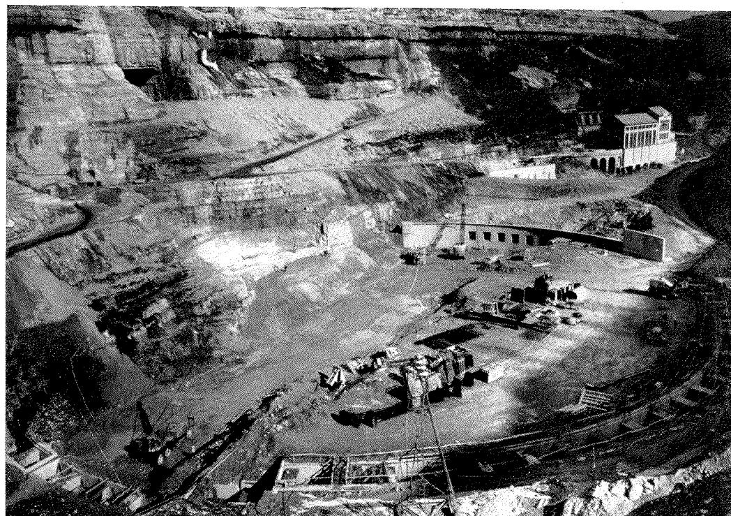
CI-DESSOUS : L'ensemble de la fouille BIOGE et, au fond, la centrale de la Chartreuse-de-Vaucluse qui disparaîtra sous la retenue.
