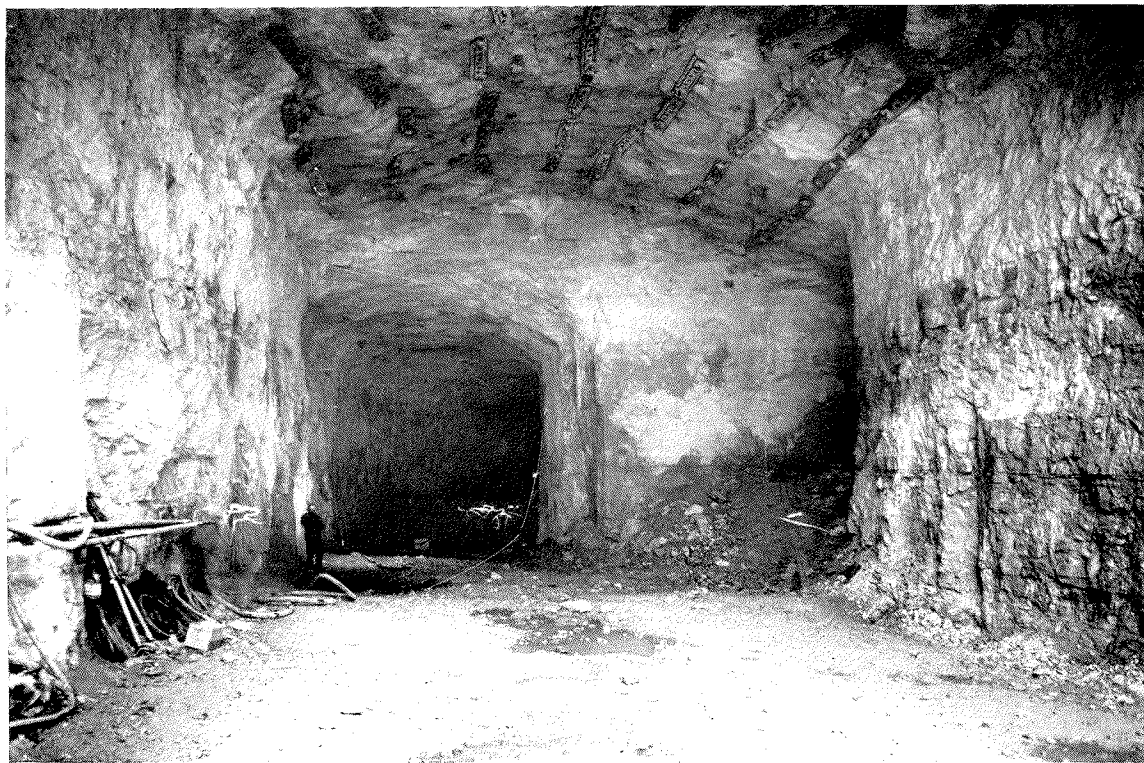
CI-DESSUS : Jonction des canaux de fuite des groupes 1 et 2.
