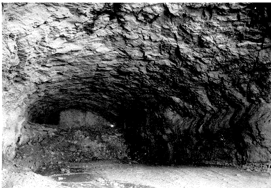
CI-CONTRE : Une des phases d'exécution de la voûte de l'Usine : l'attaque en faite.
