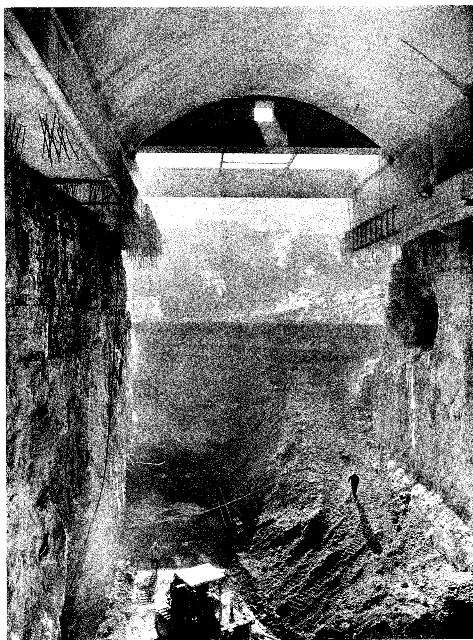
CI-CONTRE : L'excavation de l'usine souterraine atteint le niveau des fosses des sorties de roues des turbines. Le niveau du hall de montage se trouve à la hauteur du niveau du sol à l'extérieur de l'excavation.
