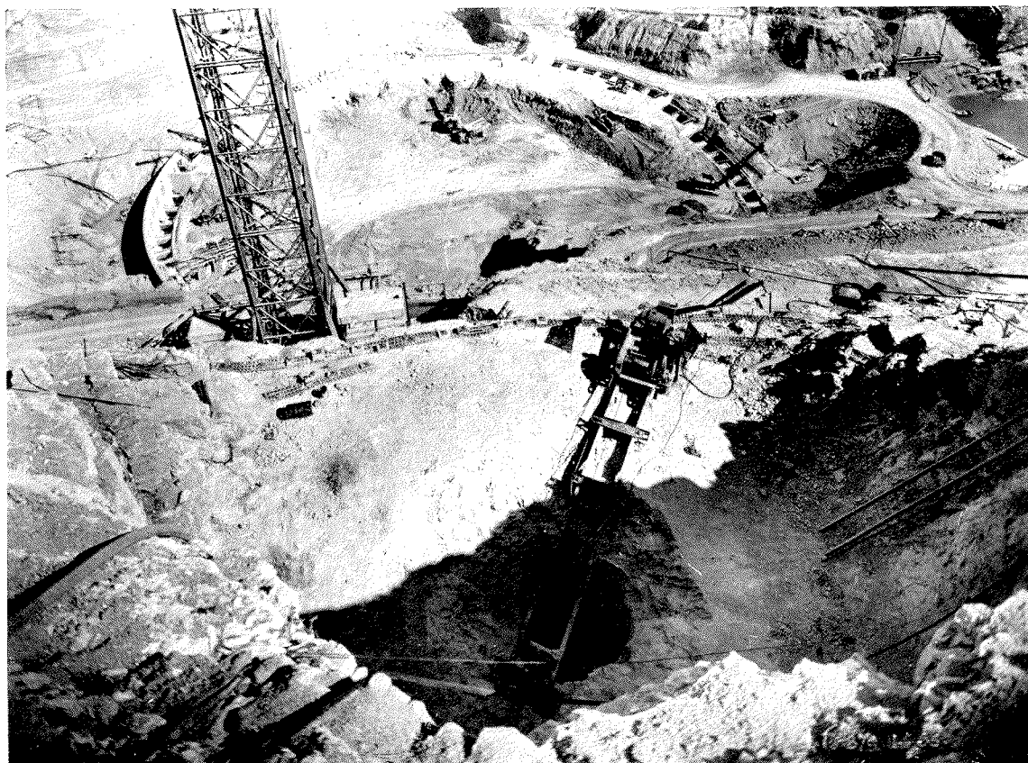
CI-CONTRE : Orifice de l'avant-puits en surface avec le treuil qui permet de soutenir la plateforme à partir de laquelle l'avant-puits sera élargi.
