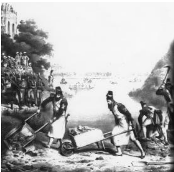
Un chantier de fortifications sur le Nil semblable sans doute à celui qui permit la découverte de la Pierre de Rosette.
